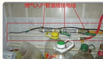
**隐患3:** 在燃气管道上缠绕电线或吊挂物品。
