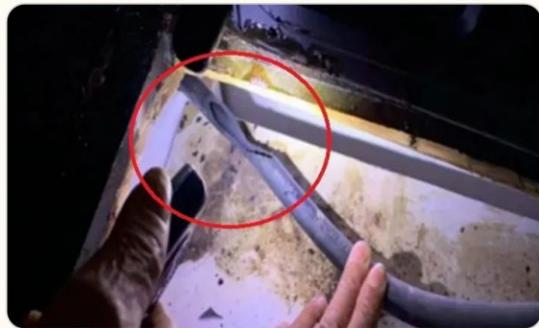
**隐患2：**橡胶管过长、无管卡，橡胶管老化（发硬、有裂纹），橡胶管超期使用（橡胶管使用期限一般为18个月）。
